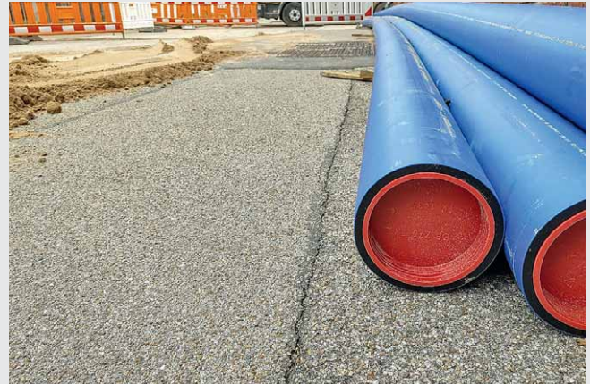
Der Ausbau der Trinkwasserversorgung in sieben Feuchtwanger Ortsteilen ist erfolgreich abgeschlossen.
