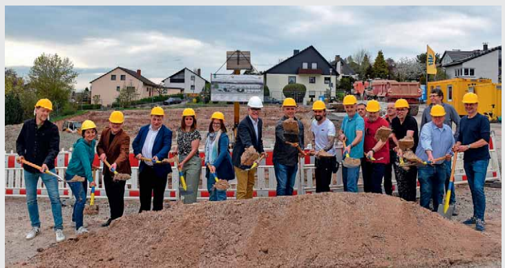
Die Stadt Feuchtwangen baut eine neue Kindertagesstätte im Wohngebiet „Röschenhof“. Den symbolisch ersten Spatenstich setzten nun Feuchtwangens erster Bürgermeister Patrick Ruh, Vertreter des Feuchtwanger Stadtrates sowie der Evangelischen Kirchengemeinde Feuchtwangen, der künftige Träger der neuen Einrichtung.
