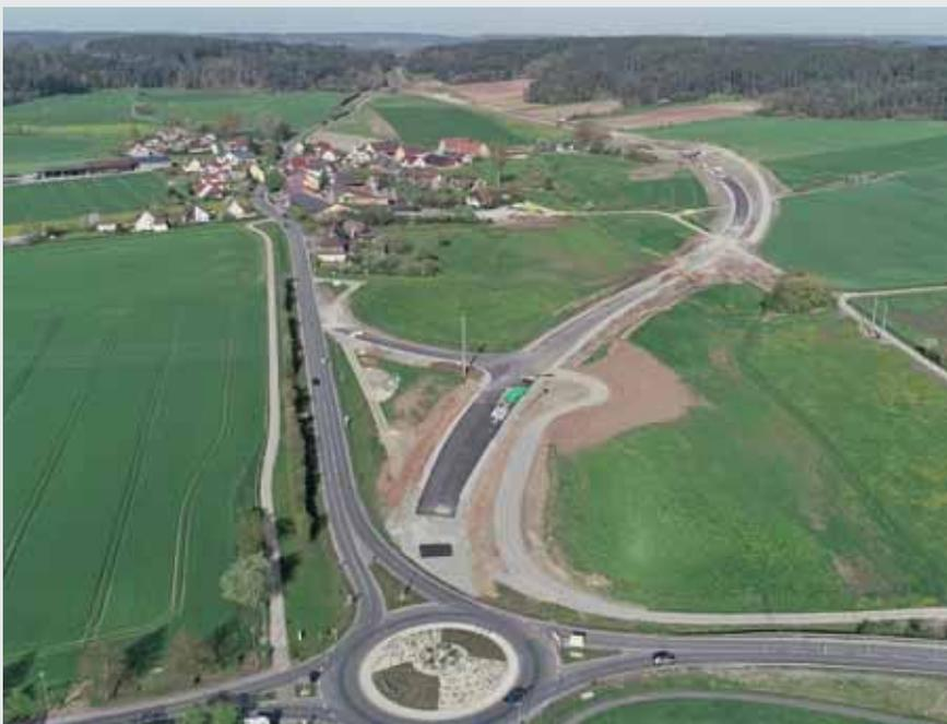
*Die neue Ortsumfahrung Sommerau nimmt Gestalt an. Im Trassenabschnitt ab dem Kreisverkehr nahe der Reha ist unter anderem bereits die erste Asphalttragschicht eingebaut.*
