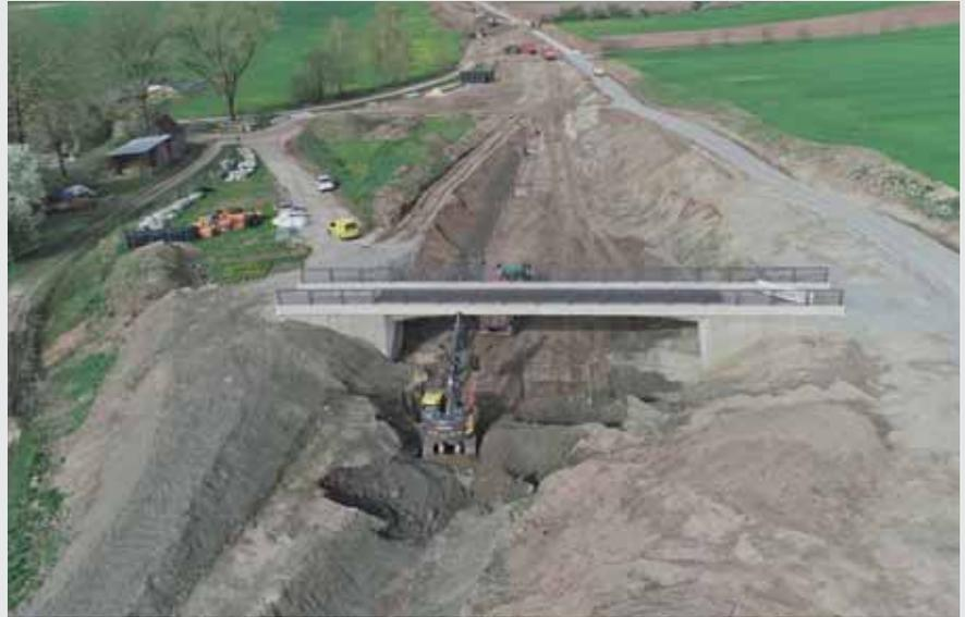
*Bereits fertig ist das neue Brückenbauwerk für die Feldwegüberführung im künftigen Verlauf der Ortsumfahrung Sommerau inklusive Geländer, Abdichtungsschicht und Profilstahl-Durchlass für das Gewässer. (Fotos: Werner Tippmann)*
