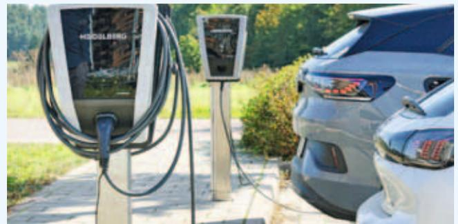
Wallboxen wie die am Campus Feuchtwangen erfassen nicht nur den Energieverbrauch, sondern auch Daten wie Netzfrequenz, Strom, Spannung und Leistung.
