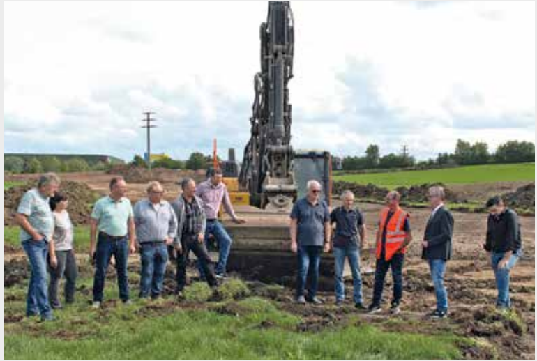
Tiefbauamtsleiter Jörg Körner (3. v.r.) informierte Bürgermeister Patrick Ruh (2. v.r.), Vertreter des Stadtrates und Anwohner vor Ort über den aktuellen Sachstand des Neubaus der Ortsumfahrung Sommerau.
