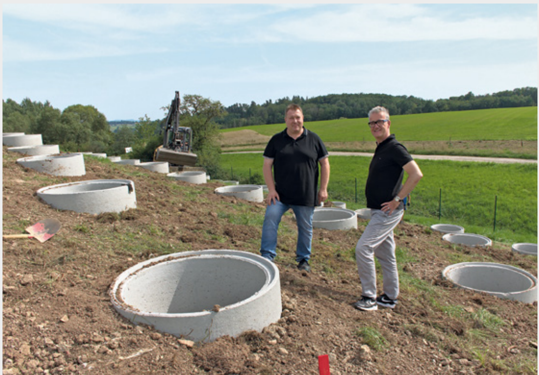
Bürgermeister Patrick Ruh (rechts) und Alexander Strauß von den Stadtwerken besichtigten die laufenden Arbeiten für die neue PV-Freiflächenanlage auf dem Gelände der früheren Deponie in Feuchtwangen. Derzeit werden rund 700 Schachtringe gesetzt, in welche dann die Unterkonstruktionen der PV-Anlage betoniert werden.
