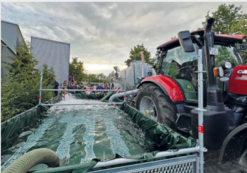
Im Außenbereich vor dem Hallenbad hat das THW für die Aktion eigens ein Becken errichtet, in das die Helfer das Wasser pumpeten. Gleichzeitig konnten die Landwirte aus diesem Becken eigenständig ihre Fässer befüllen.
