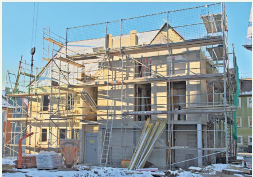
Sobald es etwas wärmer wird, können das Dach neu eingedeckt und die neuen Fenster eingebaut werden. Bereits fertiggestellt ist das Mauerwerk für den neuen Anbau, in dem ein Aufzug untergebracht werden soll.
