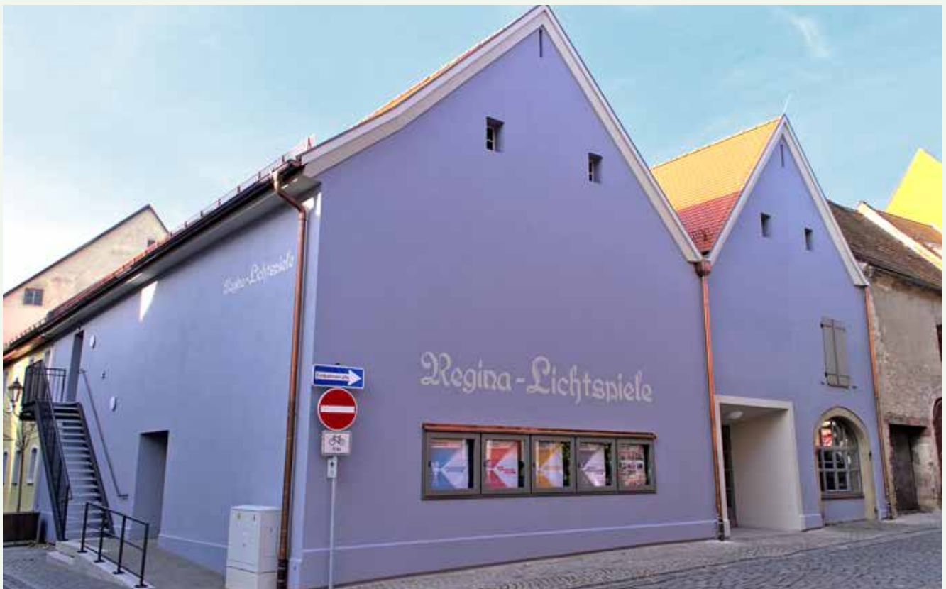
Die generalsanierten Feuchtwanger Regina-Lichtspiele feiern vom 18. bis 20. März ihre Eröffnung. Der Verein KulturKino Feuchtwangen hat für das gesamte Wochenende ein besonderes Programm zusammengestellt.
