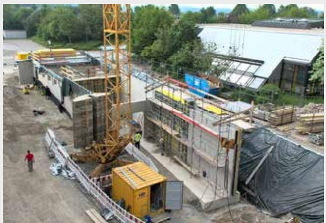
Im Nebengebäude werden aktuell die Stützwände aufgestellt, parallel konnte mit der Schalung für die Decken begonnen werden.
