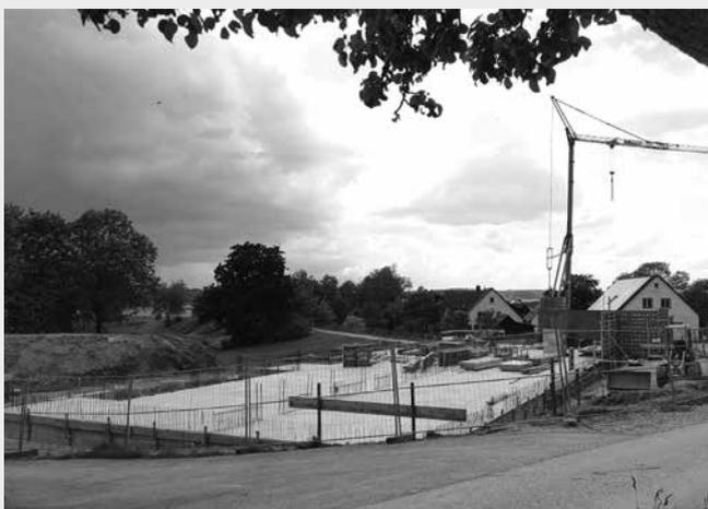
*Für den neuen Kindergarten in Breitenau ist unter anderem das Kellergeschoss bereits fertig. In den kommenden Tagen sollen nun die ersten Wandabschnitte des Erdgeschosses betoniert werden.*
