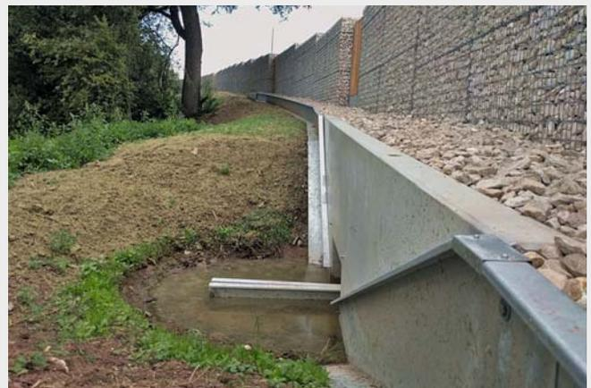
Ein Amphibienleitsystem mit speziellen Leit-Blechen entlang der Trasse und insgesamt fünf unterirdischen Durchlässen wurden gesetzt, um den Amphibien eine sichere Querung der Straße, des Radweges und des Sichtschutzes zu ermöglichen.
