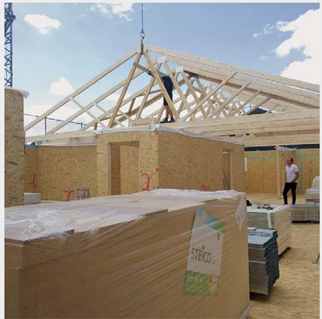
Tag 2 der Hausstellung im „Röschenhof“: Die tragenden Innen- und Außenwände des Obergeschosses stehen bereits und die Dachkonstruktion wird Element für Element angebracht. Bis zum Abend ist das neue Wohnhaus vollständig aufgebaut und regendicht.
