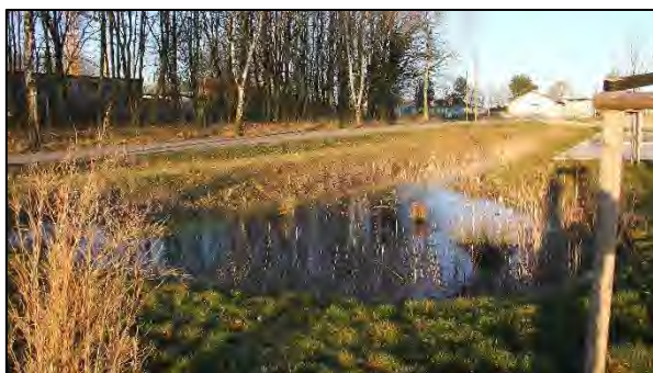
Abbildung 10: Rückhaltebecken im Südwesten des Planungsbereiches. Foto: 24.03.2020, M. Bull
