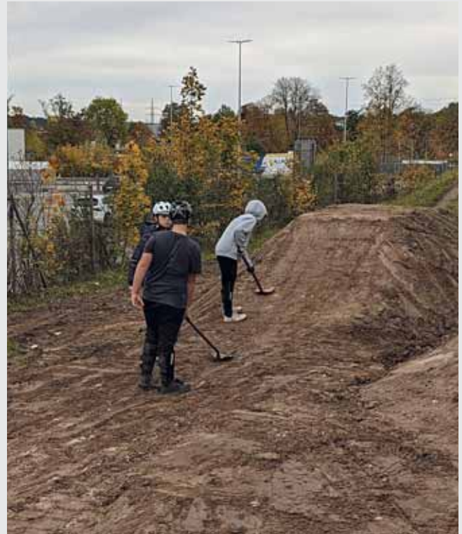
Auch die jugendlichen Dirt-Biker beteiligten sich aktiv an den Feinarbeiten der neuen Streckengestaltung.
