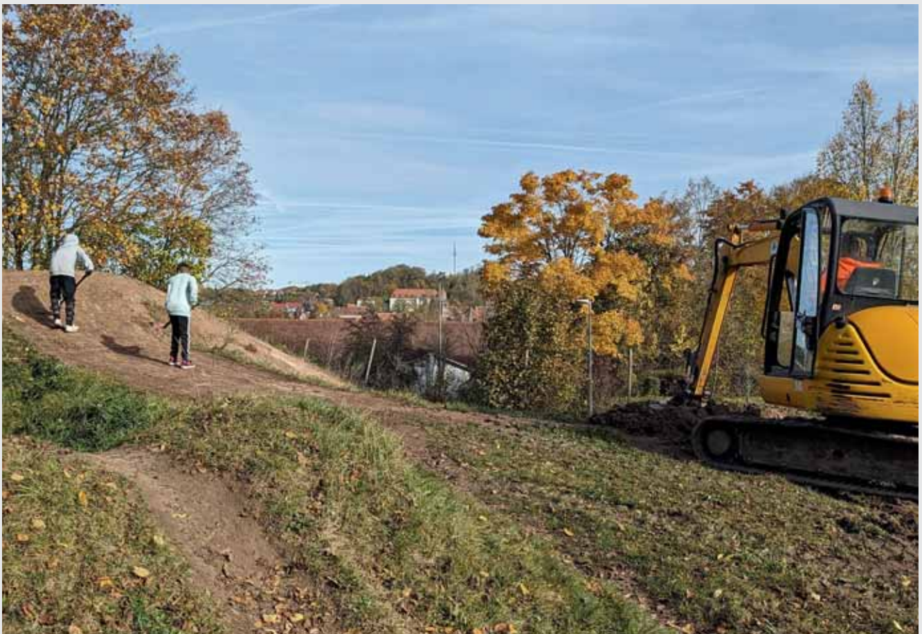
Mit Unterstützung des städtischen Bauhofs konnte die Dirt-Bike-Strecke in Feuchtwangen umgestaltet werden.
