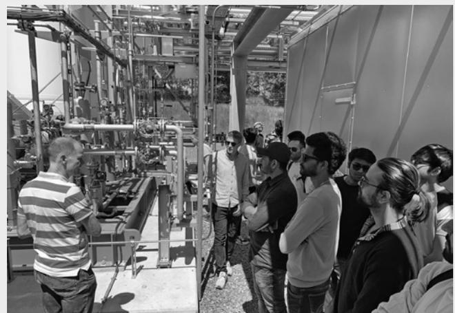
Den erzeugten Wasserstoff verfolgten die Studierenden zu den Kompressoren, die diesen verdichten, um Lagerung und Transport zu erleichtern. Durch diesen Vorgang wird die Energiedichte des Wasserstoffs erhöht.
